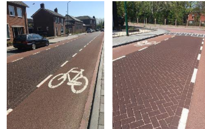
Impressie geluidsreducerende klinkers/asfalt met Streetprint
