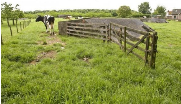
Weiland met bunkers Nieuwe Hollandse Waterlinie
