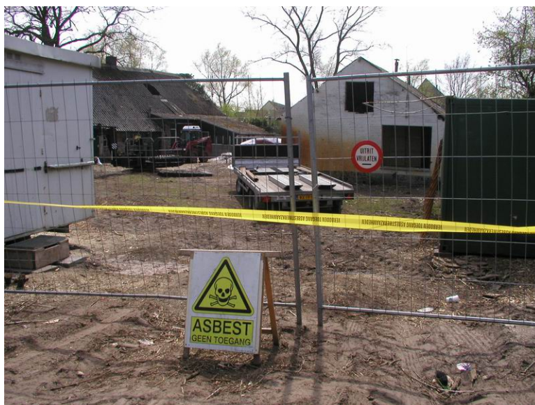
Figuur 17: Afscherming van een asbestverdachte locatie
